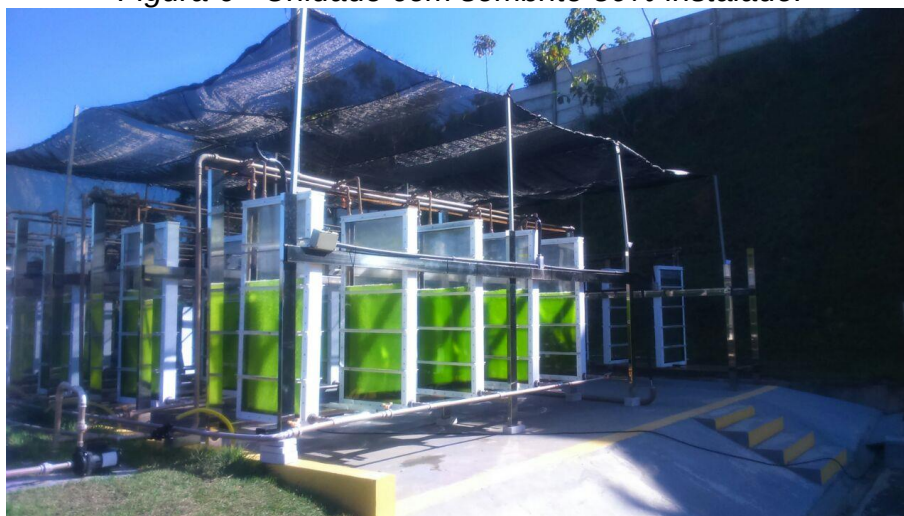
Figura 6 - Unidade com sombrite 50% instalado.
