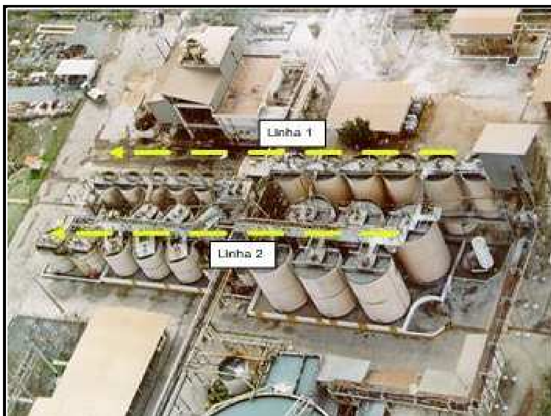
Figura 4.3: Circuito de lixiviação industrial em tanque agitado da Mineração Fazenda Brasileiro (MFB) [Fonte: Mineração Fazenda Brasileiro]
