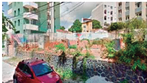
Figura 6a- Casa já demolida em dez/2011
